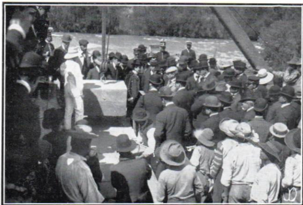
CHACRA SANA.—Colocación de la primera piedra en la nueva instalación eléctrica de Santa Rosa
