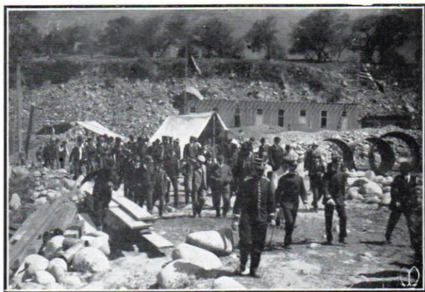
CHACRA SANA.—Después de la ceremonia de la colocación de la primera piedra
